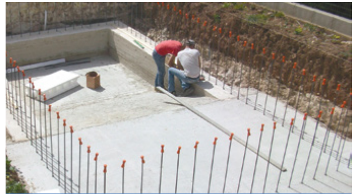
Soletta in calcestruzzo
