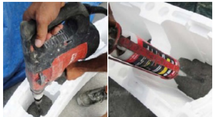
Inghisaggio armatura con collante chimico
