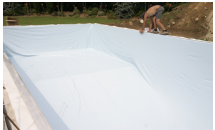
Fissaggio del liner alla guida
