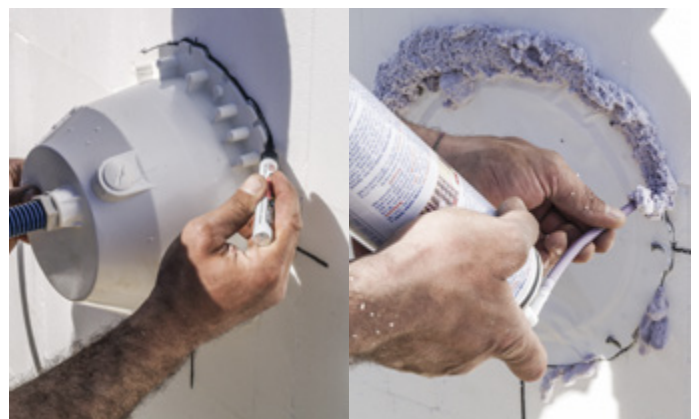
Posizionamento pezzi a murare, tracciamento e schiumatura
