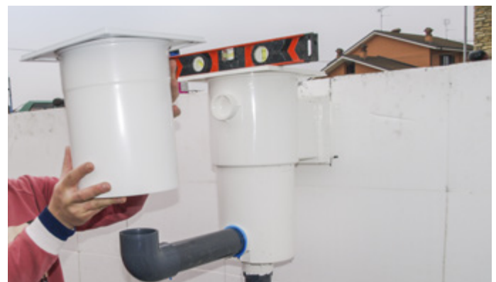
Assemblaggio del troppo pieno
