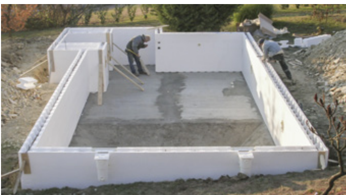
Completamento delle pareti con i casseri ISOBLOK
