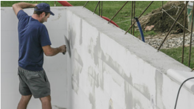
Stuccatura delle imperfezioni sulle pareti piscina
