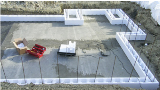
Posa dell'armatura verticale
