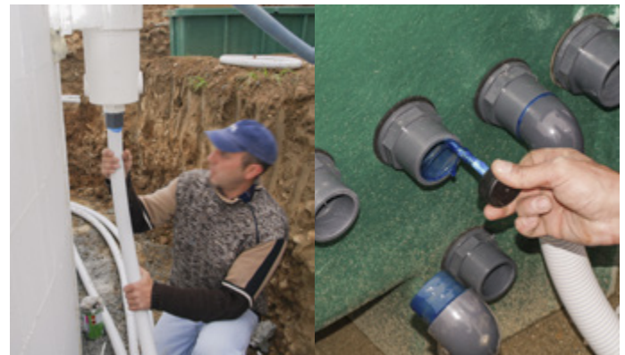
Collegamento idraulico dei pezzi a murare
