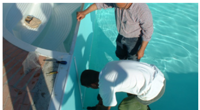
Fissaggio dei pezzi speciali - scala in vtr
