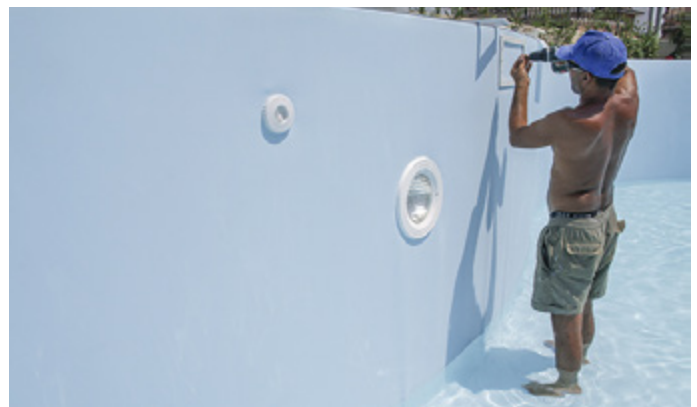
Fissaggio dei pezzi a murare
