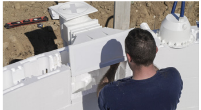
Posizionamento pezzi a murare (inserimento sagoma)
