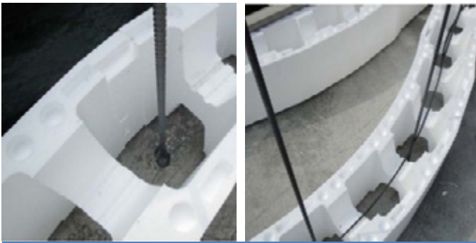
Inghisaggio e posa armatura verticale ed orizzontale
