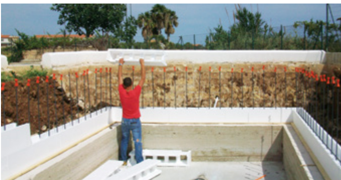
Posa della linea di corso con i casseri ISOBLOK
