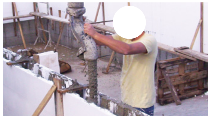
Getto del calcestruzzo
