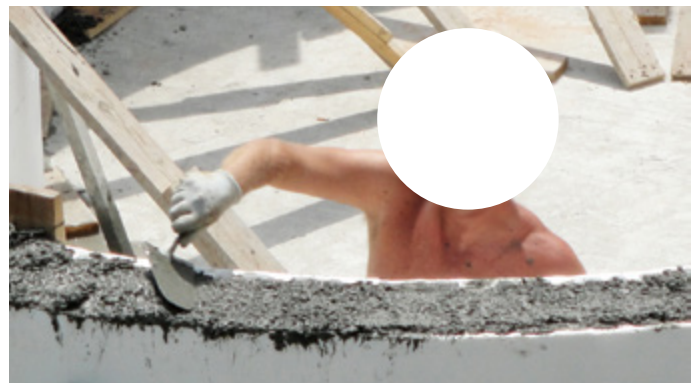
Livellamento della superficie
