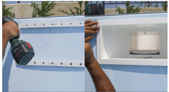
Fissaggio dei pezzi a murare
