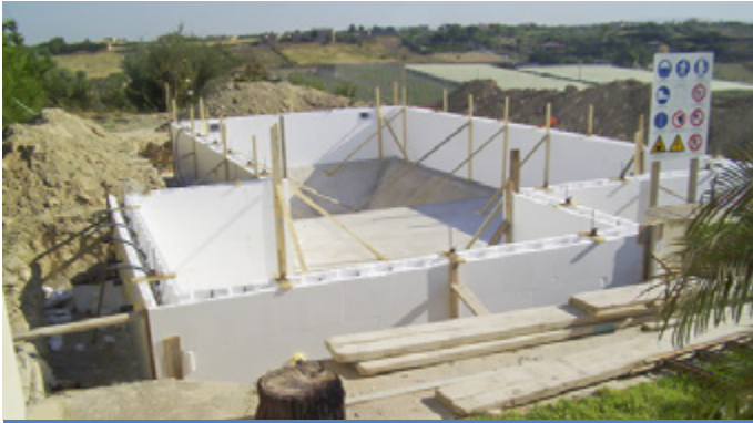
Operazione di controventatura dei casseri ISOBLOK
