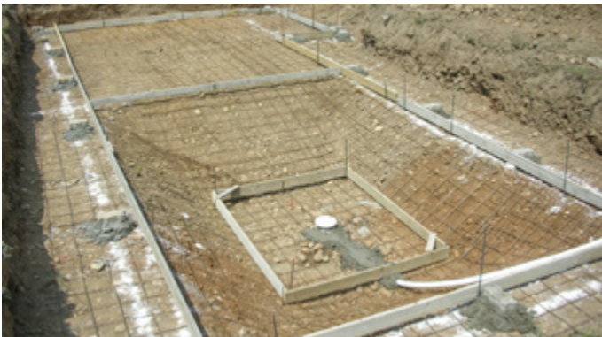
Stesura delle reti elettrosaldate
