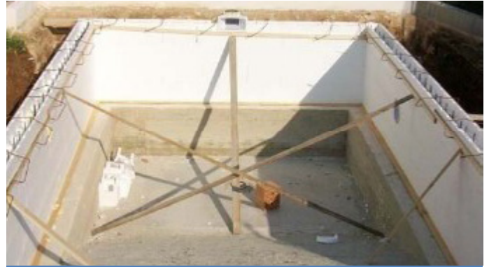
Operazione di controventatura dei casseri ISOBLOK
