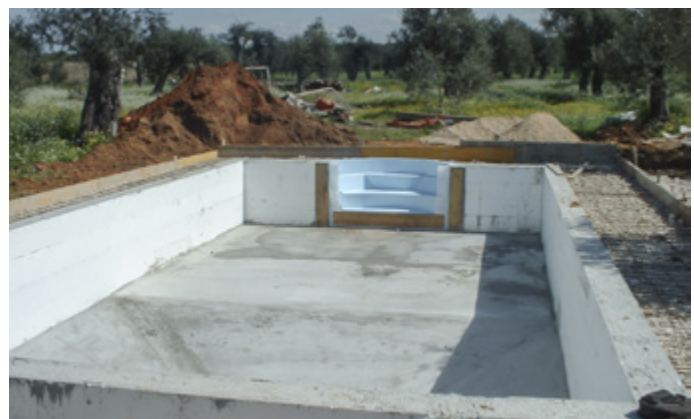
Getto di cemento completato
