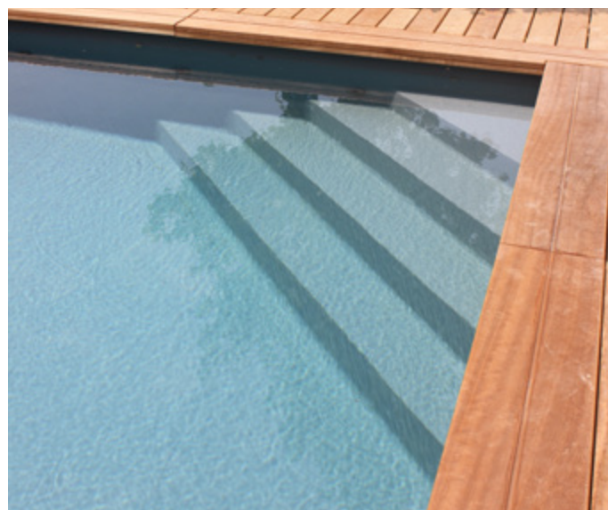
Installazione finita di una scala d'angolo sotto il rivestimento
