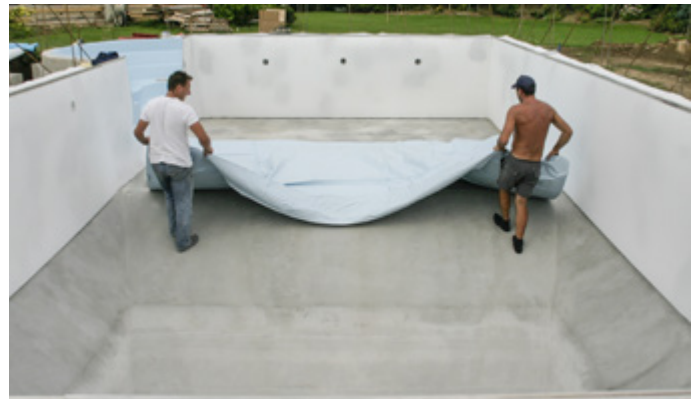
Stesura del liner all'interno della piscina
