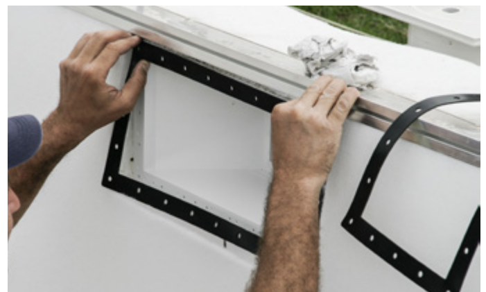
Posa delle guarnizioni degli accessori
