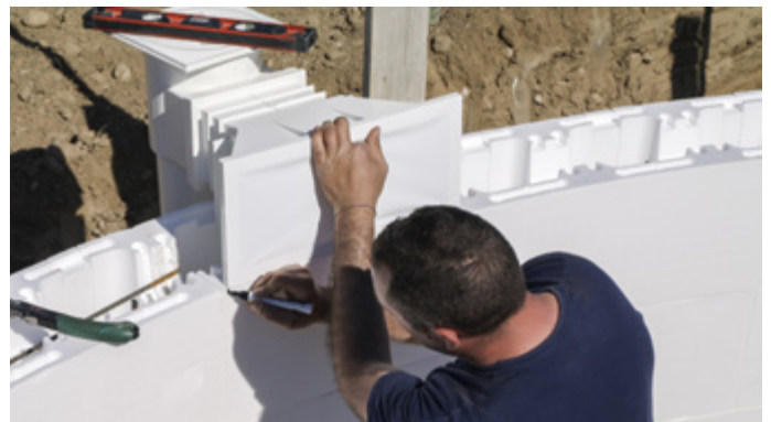
Posizionamento pezzi a murare (tracciatura sagoma)
